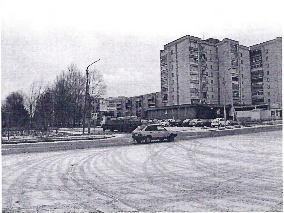
фото 2. Отсутствие дорожной разметки.
