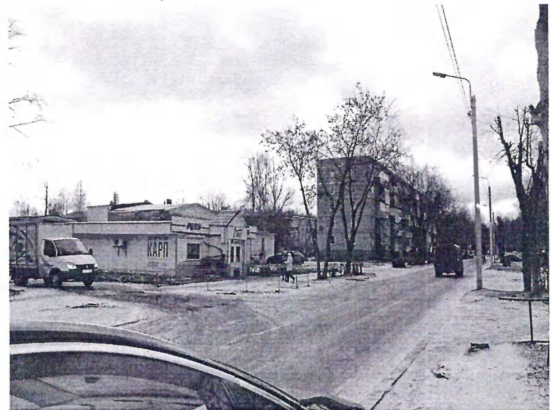
фото 3. Отсутствие дорожной разметки.
